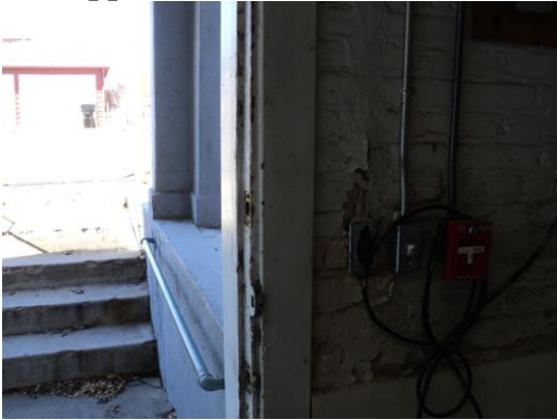
#10 Upper Basement Wall 3 Door
